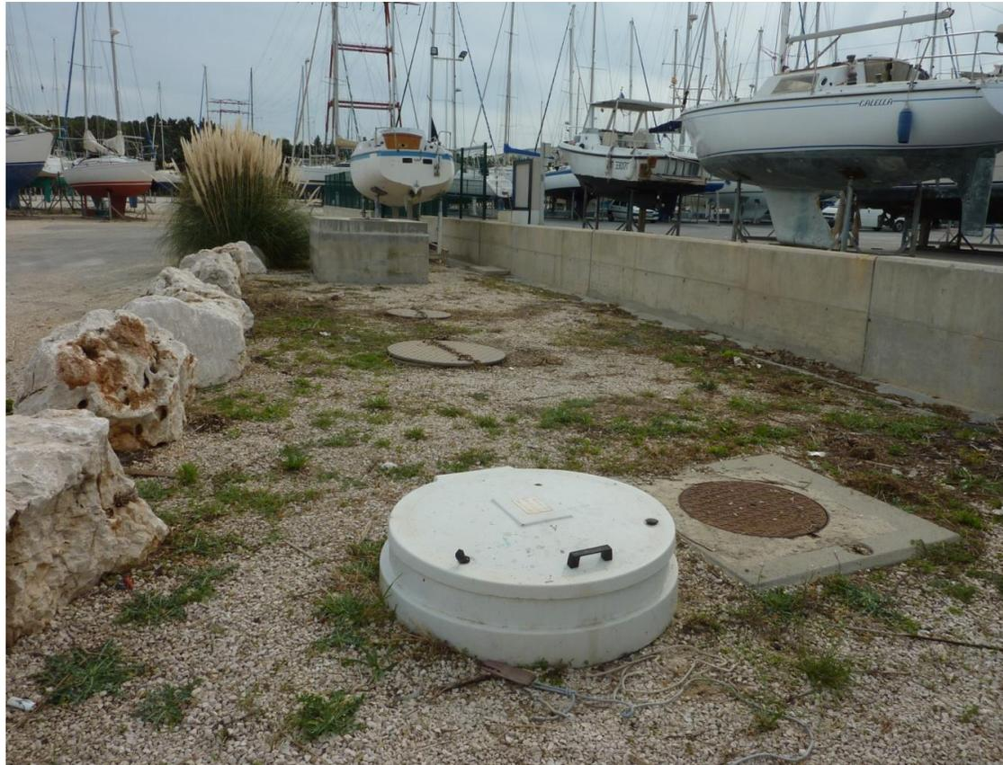
*Décanteur particulaire des eaux issues des travaux de carénage*
