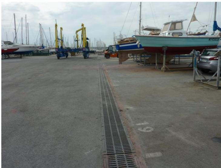
*Caniveau de récupération des eaux issues des travaux de carénage*
